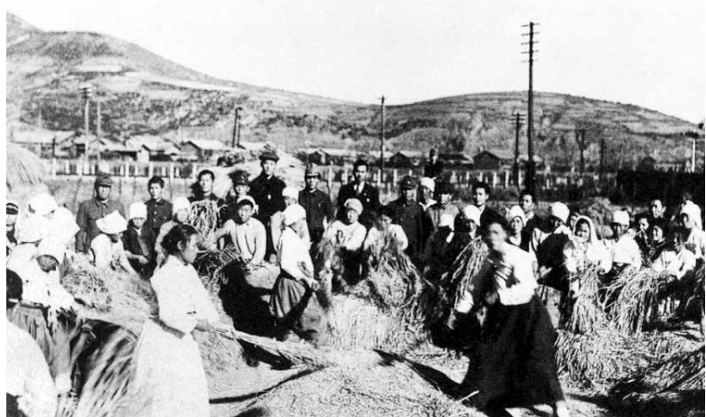
한창 탈곡중인 주민들 뒤로 남조선철도사무소 설치 이후 조곡동 일대에 들어선 관사 100여 채와 순천역 등 77동의 철도 관련 건물들을 볼 수 있다.
