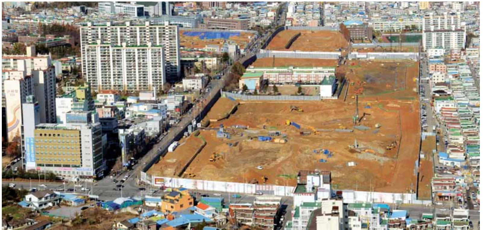
하계 U대회 선수촌 아파트 터파기 토목공사 65% 순조
