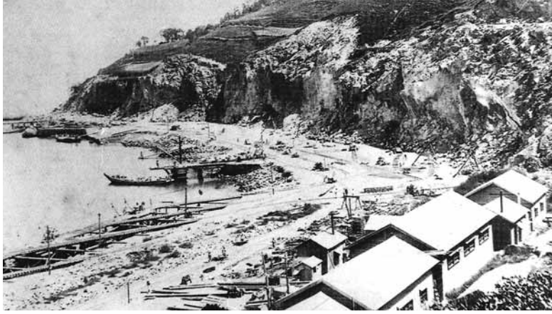
1935년 오동도 입구쪽 신항의 매립공사 장면.
