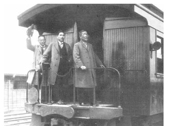
터널공사·철도 노동자 파업 등 우여곡절을 거쳐 애초 준공시기보다 두 달여 늦은 1930년 12월 개통되는 광주~여수선의 첫 기차에 시승한 사람들.
