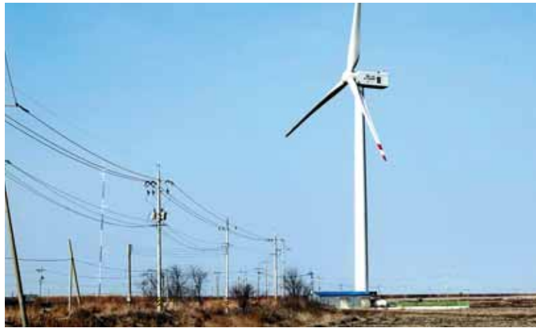
28일부터 시험가동에 들어간 영광지산풍력발전소. 높이 80m, 날개에 해당하는 블레이드 길이가 44m에 달하는 초대형 발전기들로 구성된 이 발전소의 발전용량은 우리나라 최대인 3MW급이다. /영광=조익성기자 ischo@
