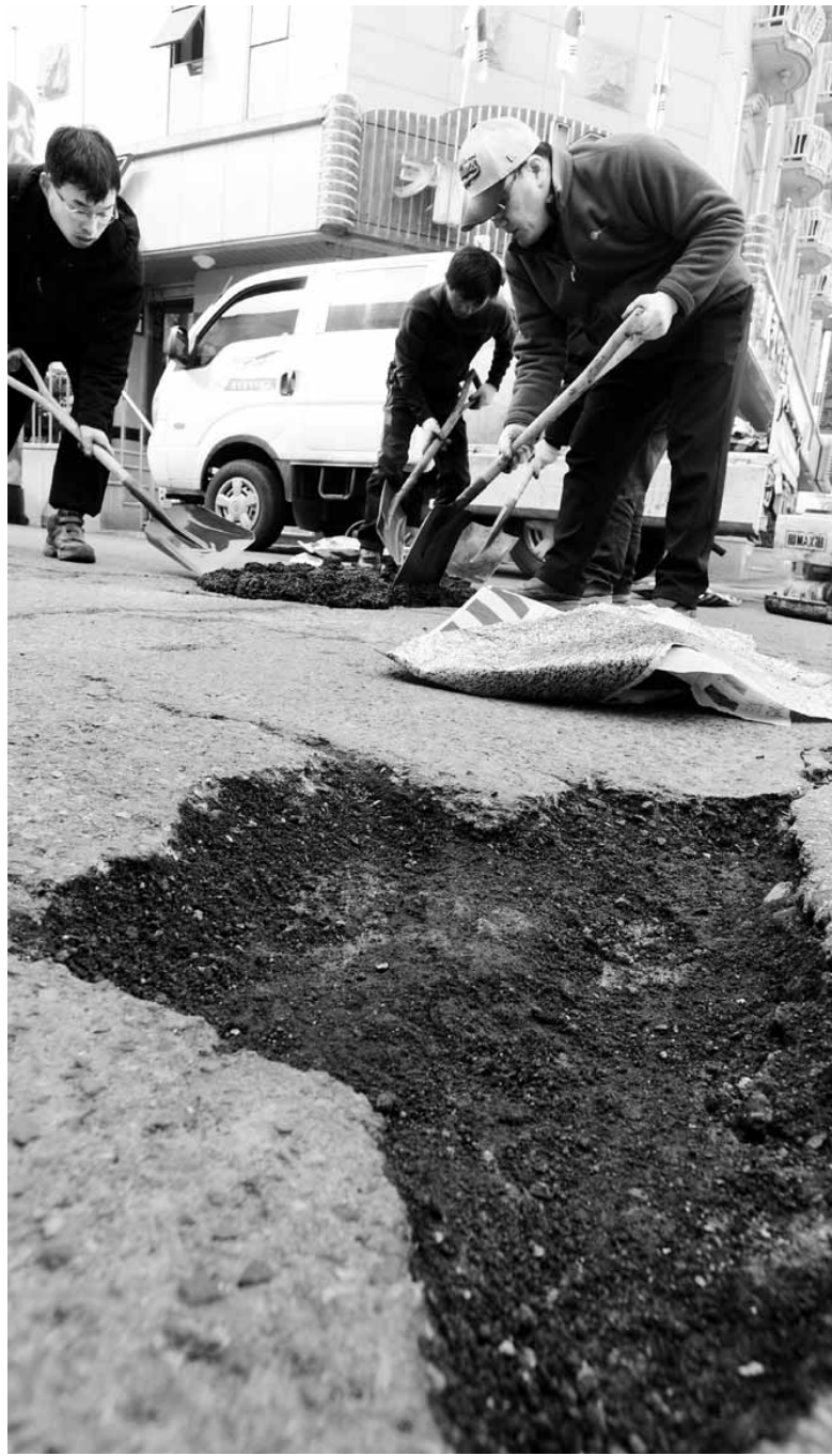
파손된 도로 메우기
