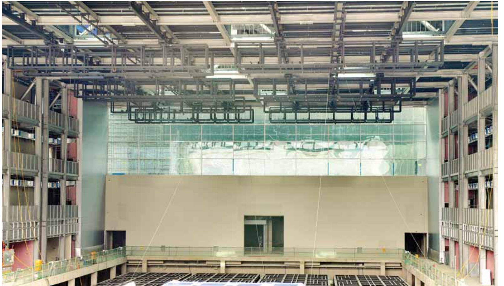
아시아예술극장 내부 공사 한창
