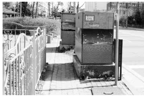
광주시내 곳곳 인도에 설치된 변압기.
