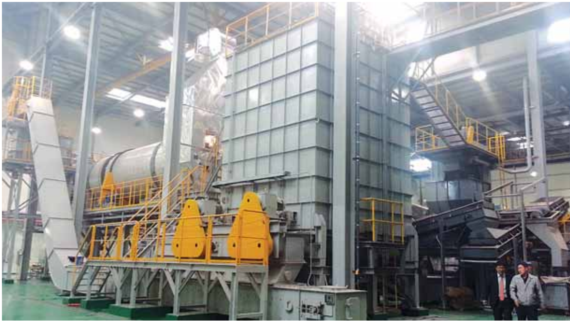
세종시 가림동에 위치한 가연성폐기물연료화(RDF)시설 내부. 3층 높이의 밀폐된 건물 내부에 크레인과 파쇄기, 크기 선별기, 운반용 트레일러, 건조기 등이 들어서 있다. 오른쪽은 RDF시설에서 만들어진 엄지손가락 크기의 펠릿.
