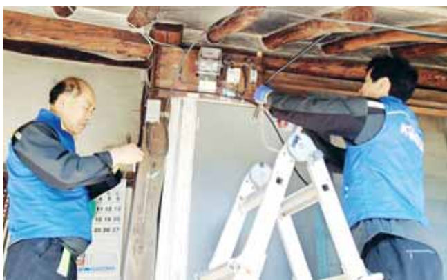
코레일 전남본부 전기분야 기술봉사회 직원 20여 명은 최근 순천시 흥내동의 흠뻑 사는 노인 가정을 찾아 노후한 전기설비를 보수하고 미용봉사 활동을 펼쳤다. <코레일 전남본부 제공>
