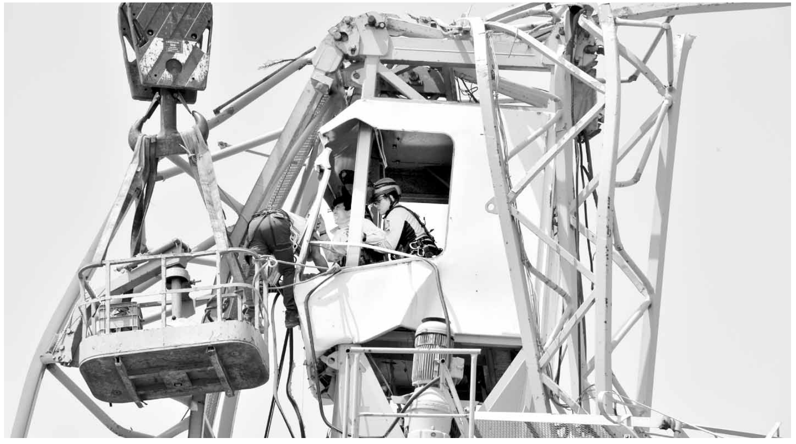
12일 오전 10시40분께 목포시 용해동 용해지구 아파트 건설공사 현장에서 대형 크레인인 넘어져 5명의 사상자가 발생했다. 이 날 크레인 기사 서모(47)씨는 출동한 119에 의해 사고 발생 3시간 만에 지상 40m 높이의 운전석에서 구조됐다.
