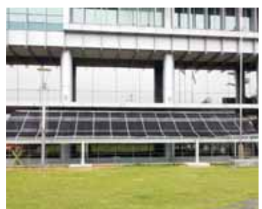
군은 실험기동 및 시설물 검사 등을 거쳐 오는 29일 준공검사를 마칠 예정이다. 태양광시설을 통해 1일 229kw, 연간 8만3500kw의 전기가 생산될 것으로, 군은 예상하고 있다. 이는 지난해 군청사의 연간 전기사용량 175만8108kw의 5% 수준으로 에너지 절감은 물론 연간 1100만원의 절약을 할 수 있을 것으로 보인다. 군 민생경제와 관계자는 "부안은 전국 최초의 신재생에너지 특구로 신재생에너지산업의 상징적·선도적 지역"이라며 "신재생에너지산업의 경쟁우위 및 산업을 위해 박막형 모듈을 설치했다"고 강조했다. /부안=정재욱기자 jyj0681@
