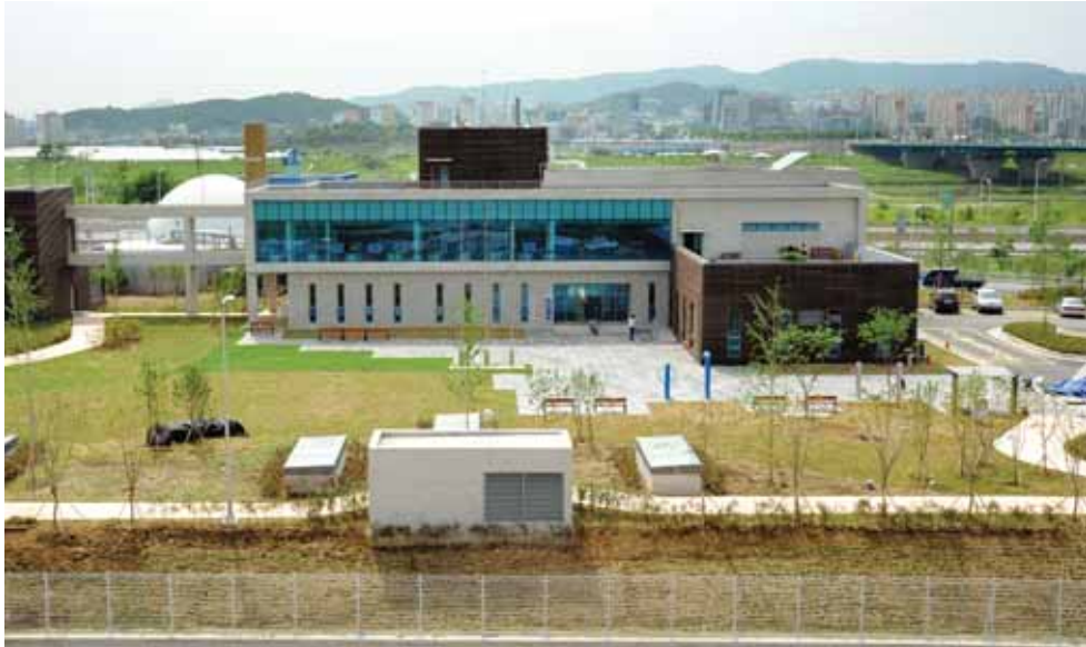
광주시 '제2음식물자원화시설' 전경(왼쪽). 지상2층 지하3층 규모의 이 시설에는 음식물을 처리하는 모든 장비가 지하에 갖춰져 있어 소음과 악취를 예방하고 있다.
