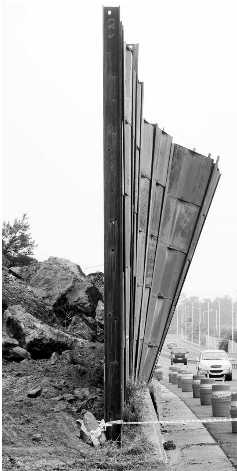
"조형물 아냐, 낙석방지 시설인데..." 24일 광주시 서구 응두동 국가지원도로 공사현장에 설치된 낙석방지시설(높이 6m)이 무너져 내린 돌의 무게를 이기지 못해 도로로 쓰러질 듯 기울어져 있다. /김진수기자 jeans@kwangju.co.kr
