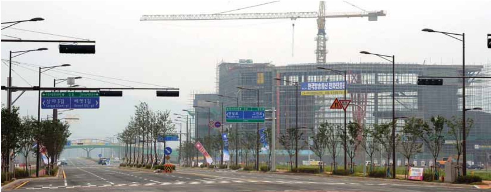
정부가 혁신도시 이전기관들의 종전부동산 판매를 돕는 것을 골자로 하는 '혁신도시 개발 촉진 방안'을 발표해 나주 빛가람도시 조성 사업이 더욱 탄력을 받게 됐다. 사진은 한국방송통신 전파진흥원 나주 신사옥 공사 모습. /나주특기기자 mjna@kwangju.co.kr
