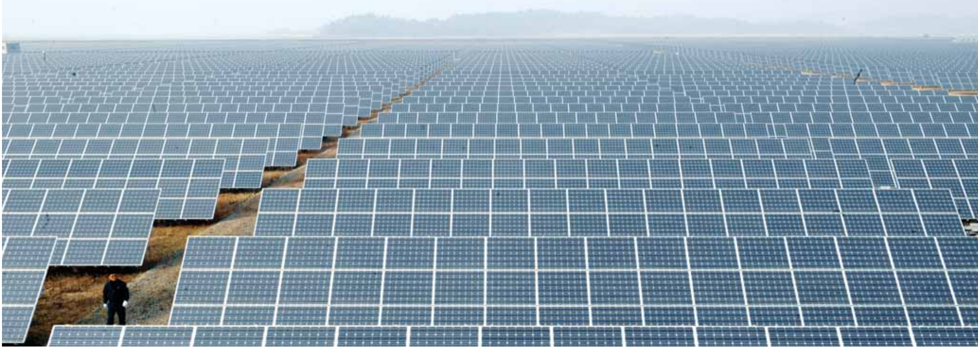
신안에 설치된 태양광 발전소 전경. 동구 용연정수장 등 광주지역 상수도시설 유휴부지에도 이같은 태양광발전소가 들어설 전망이다.
