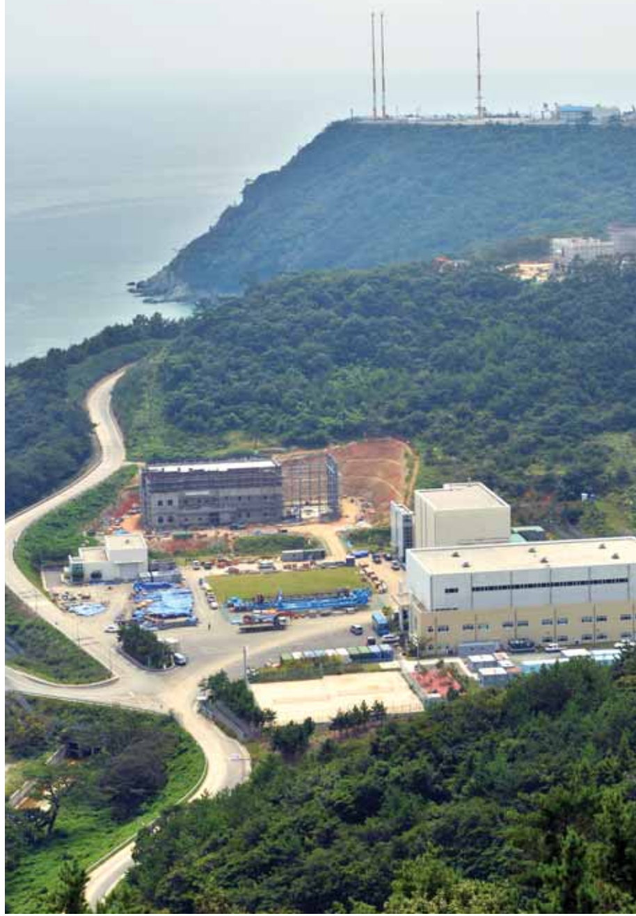
2단계 확충공사가 진행중인 나로 우주센터의 모습. 앞쪽에 짓고 있는 건물이 제어계측동. 뒤쪽으로 연소기, 터보펌프 시험설비 공사 현장과 멀리 제1 발사대가 보인다.
