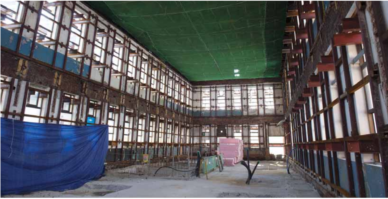
광주시 동구 광산동 국립아시아문화전당 건립 부지 내 옛 경찰청 민원실에 대한 시설보강과 내부 리모델링 작업이 진행되고 있다. 벽돌과 나무로 지어진 이 공간은 노후화 때문에 강철프레임을 외부에 설치하는 등 보강공사가 이뤄진 상태로, 향후 문화전당의 전시관으로 활용될 예정이다. /최현배기자 choi@kwangju.co.kr
