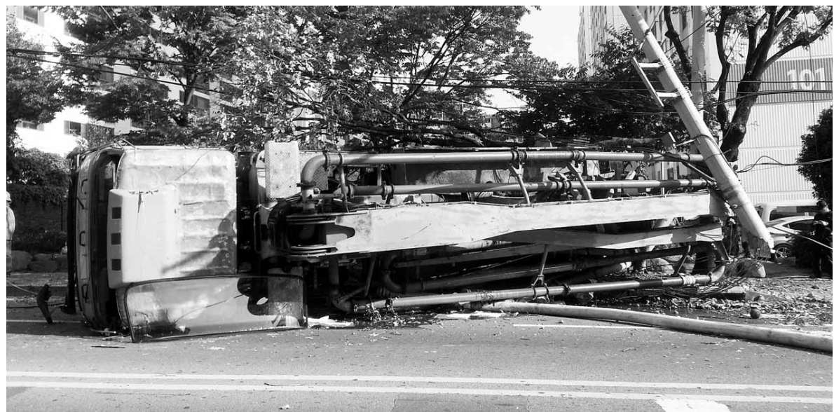
도로 덮친 펌프카...4명 부상 29일 오후 3시 40분께 광주시 북구 문흥동 모아아파트 앞 사거리에서 허모(44)씨의 펌프카가 300m가량 뒤로 미끄러지면서 보행자·승용차를 친 뒤 도로 바닥에 넘어져 있다. 이날 사고로 보행자 2명·승용차 운전자 2명 등 4명이 중·경상을 입었다. 경찰은 오르막길에서 갑자기 펌프카가 뒤로 밀렸다는 허씨의 진술을 토대로 정확한 사고원인을 조사 중이다. <광주북부소방서 제공>
