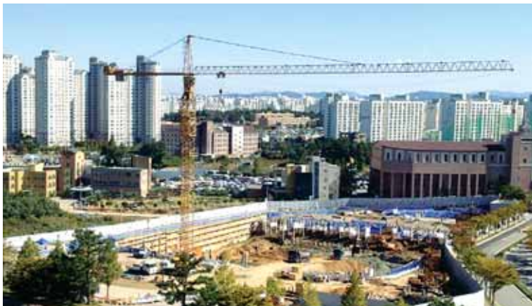
광주여자대학교내에 공사중인 다목적체육관.
