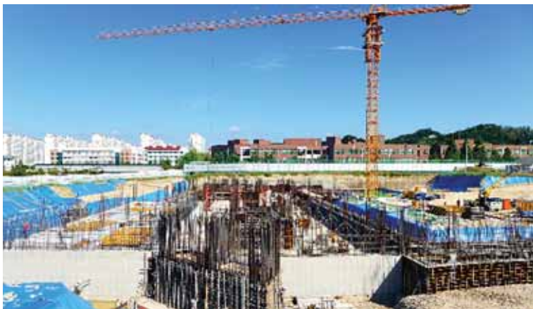
첨단지구 남부대학교에 들어서는 수영장 공사 현장.
