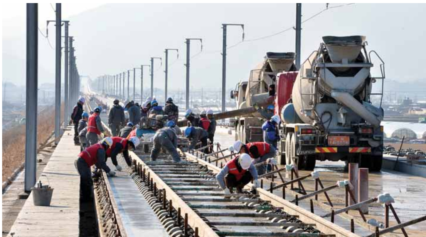
빠름을 위해 "천천히" 지난 24일 전북 정읍역에서 광주방면으로 10km 떨어진 KTX 호남선 공사현장에서 인부들이 콘크리트 궤도 타설 공사를 하고 있다. /최현배기자 choi@kwangju.co.kr
