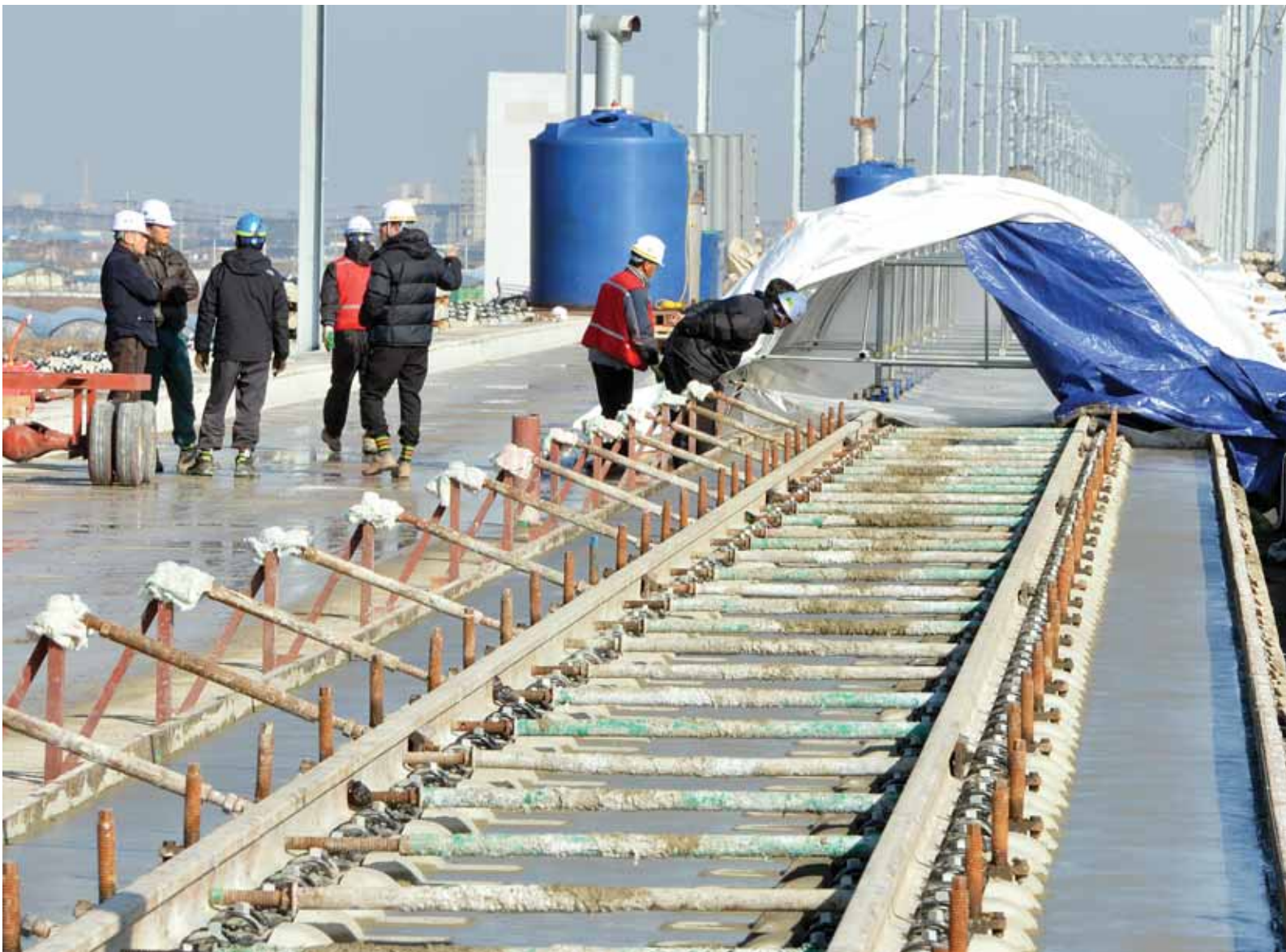
아침 최저기온이 영하 6도를 기록한 9일 전북 정읍역에서 광주방향으로 10km 떨어진 KTX 호남선 콘크리트 궤도 타설 공사현장에서 인부들이 콘크리트 치기가 끝난 다음 온도·하중·충격 등 유해한 영향을 받지 않도록 보호·관리하기 위해 비닐하우스를 친 뒤 스티트보일러를 작동하고 있다.
