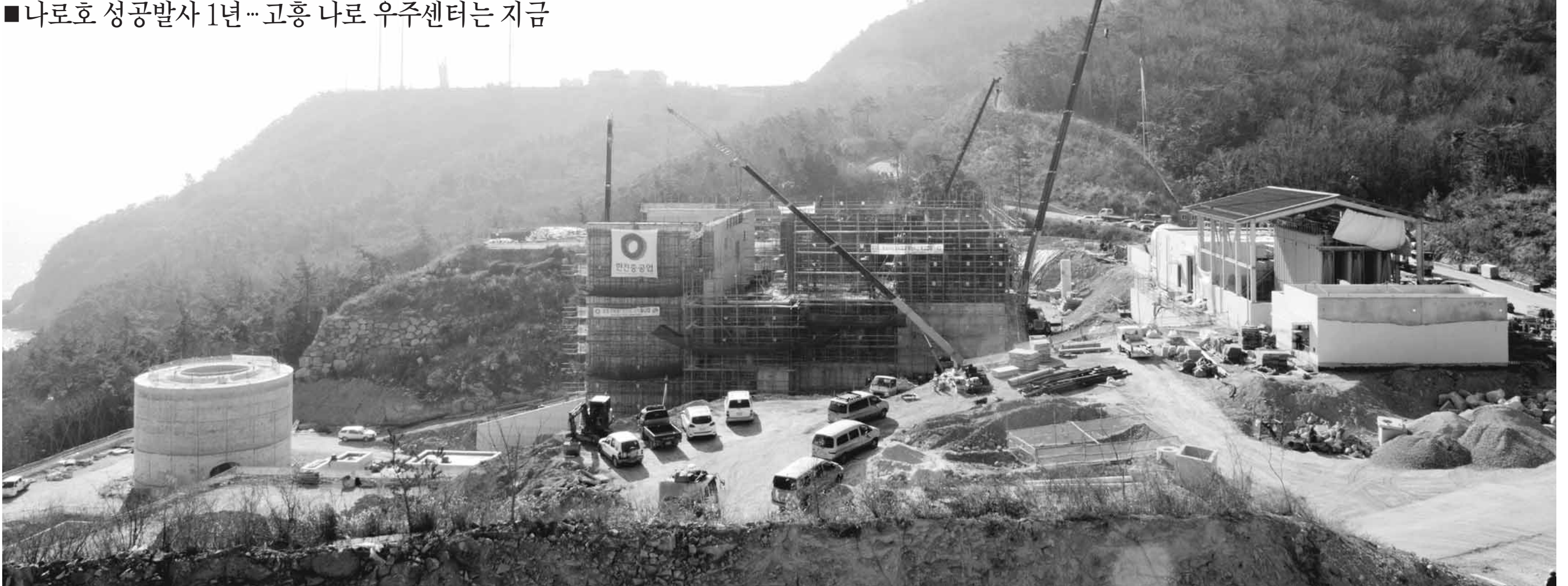
한국형발사체 추진기관 핵심시설인 연소기 시험설비 공사가 한창이다. 멀리 산 중턱에 나로호 발사대가 보인다.
