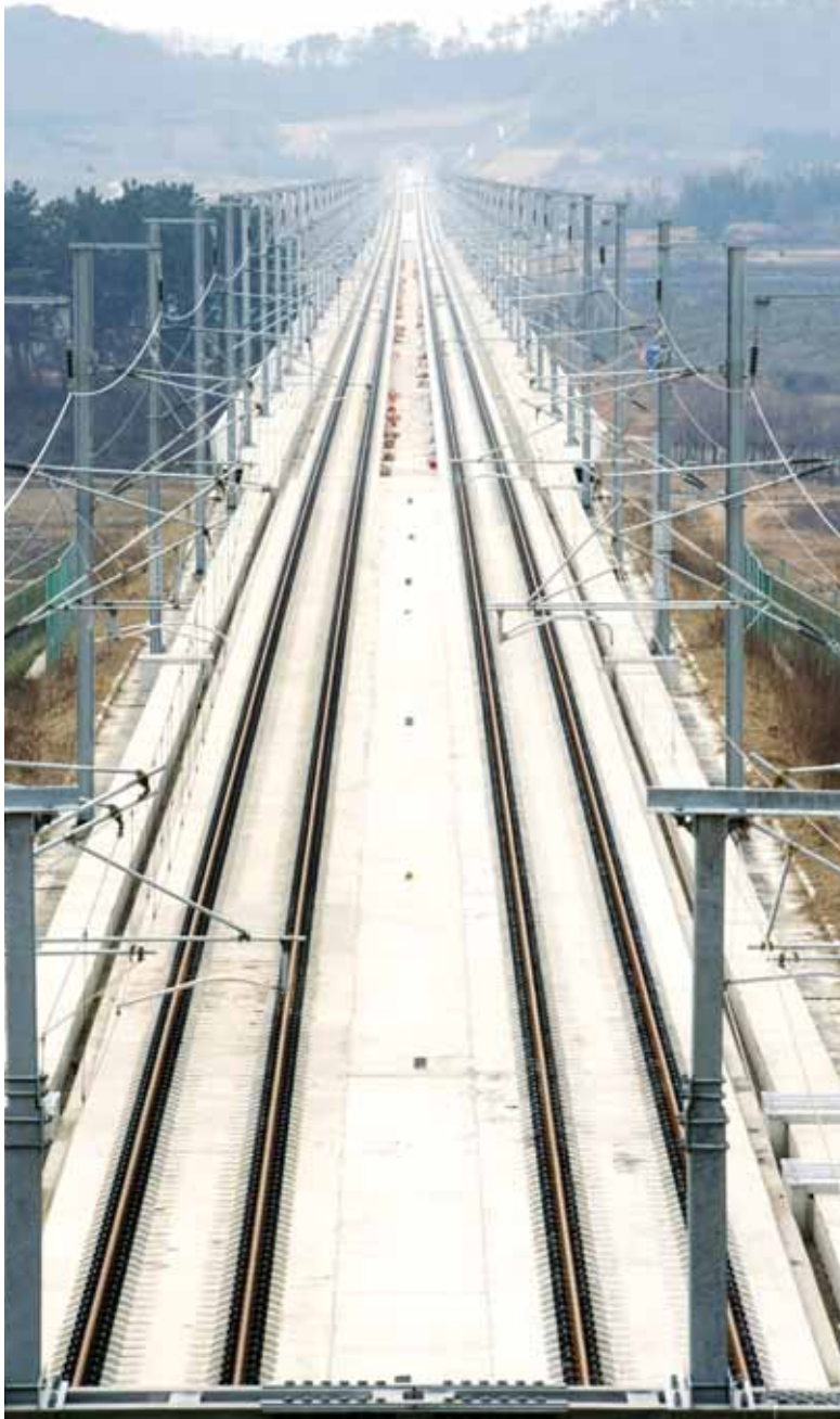
호남고속철도 2단계 광주 송정~목포 구간의 착공 시기가 불투명해지면서 2017년 완공을 장담할 수 없게 됐다. 사진은 익비지 공사 중인 호남고속철도 전북 정읍시 정우면 회룡터널 구간. /최현배기자 choi@kwangju.co.kr
