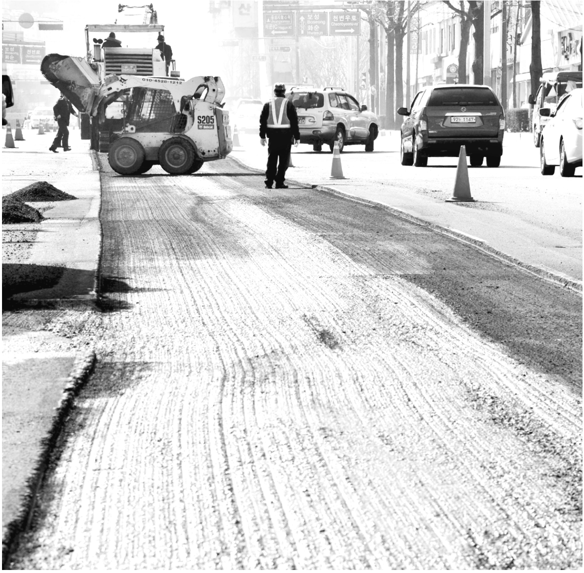
봄맞이 도로 보수공사 광주시중합건설본부 소속 공무원들이 5일 광주시 동구 학동삼거리 앞길에서 포트홀(이스콘 파손)이 발생한 이스콘을 걷어낸 뒤 덧씌우기 보수공사를 하고 있다. 시중합건설본부는 이번 주까지 학동삼거리~원지고 구간(470m)에 대한 도로포장 보수공사를 할 계획이다. /N명주기자 mjna@kwangju.co.kr
