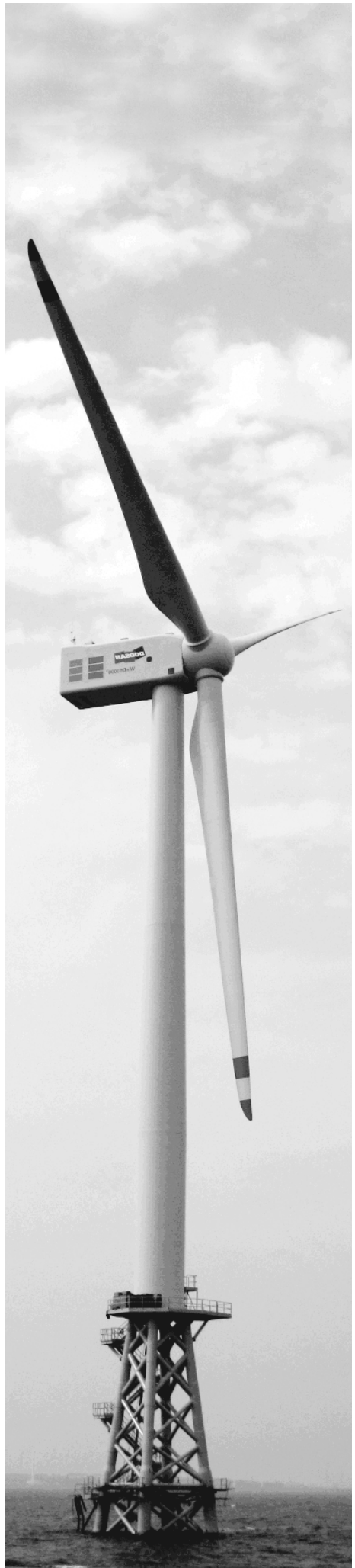
제주시 구좌읍 행원리 시범운영중인 해상풍력발전기 모습.
