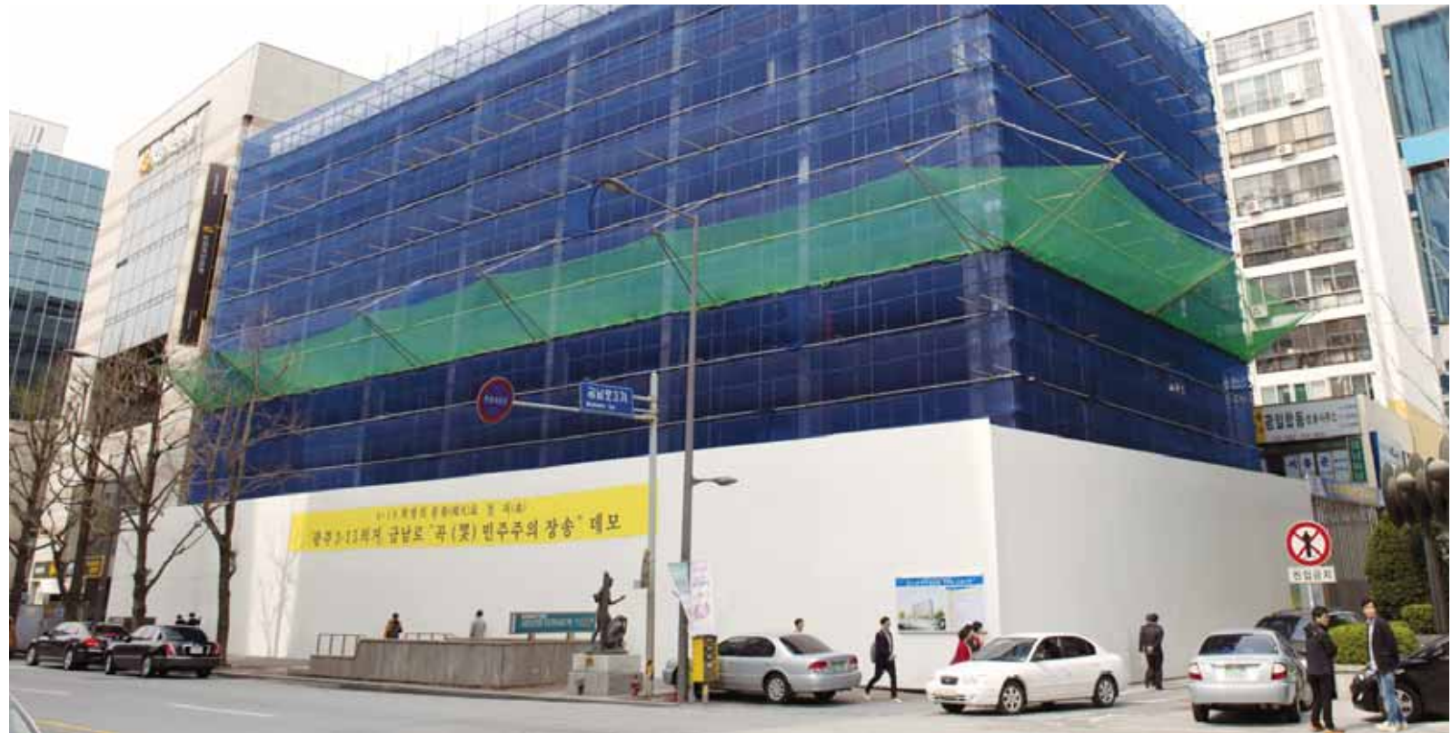
5·18 아카이브 건립 공사 한창 탈바꿈한다.
