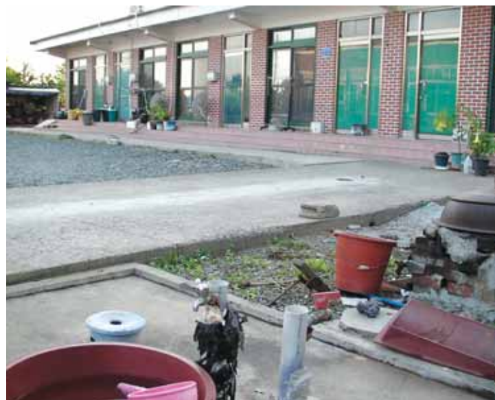
현애원 양로원 마당에 설치된 지하수.
