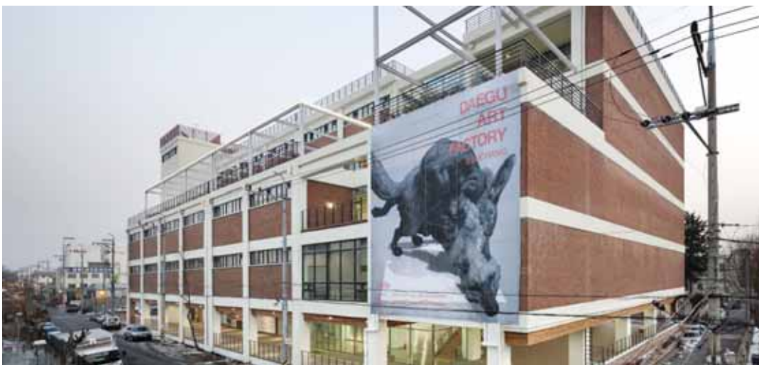
총 160억 원을 들여 리모델링한 대구예술발전소 전경.
