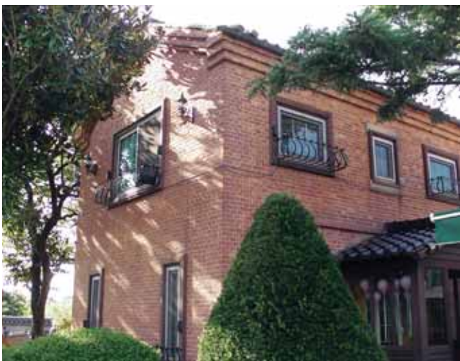
옛 동양척식주식회사 문서고 건물.
