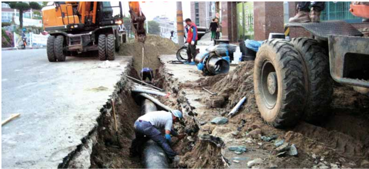
목포시는 올해 6억여 원을 들여 5개소 1874m의 노후 배수관을 교체했다. 사진은 죽교동 북교초교~순천당 약국 간 공사 현장 모습.
