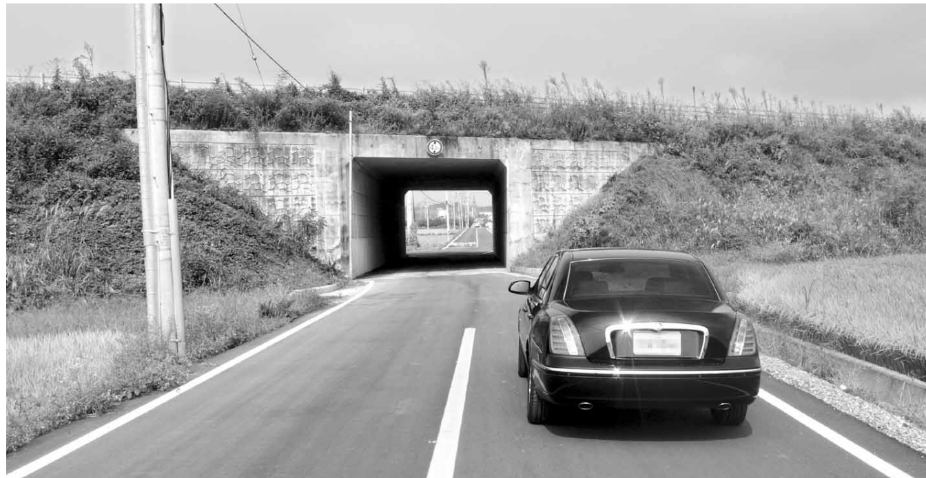
도로보다 폭이 좁은 통로박스가 한 차선을 가로막은 나주시 다시간 북암리 인근 농도(農道). 주민과 운전자들은 통로박스의 확장에 앞서 야간 통행차량들의 안전을 위한 모래벽과 과속방지턱 등 안전시설을 설치해 달라고 있다.
