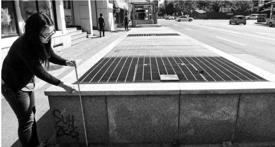
광주일보 취재진이 19일 오후 광주시 동구 금남로4가역 환기구(가로 2.5m·세로 13m·높이 50cm) 규격을 측정하고 있다. 환기구는 초등학교도 쉽게 올라갈 수 있을 정도로 낮았지만 경고 문구나 안전장벽 등은 전혀 없었다. /김진수기자 jeans@
