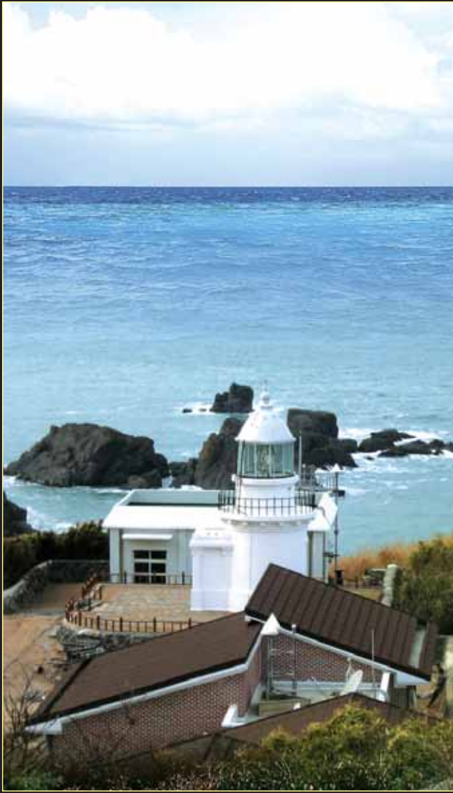
우리나라 최 서남단에 위치한 가거도 등대 전경. 등대는 멀리서 보기에 아름답지만 절벽 위의 외로운 집 같은 곳이다. 백색의 등탑은 7.6m로 야간에 700와트짜리 램프가 15초마다 섬광을 발사해 가시거리가 약 50km에 이른다.
