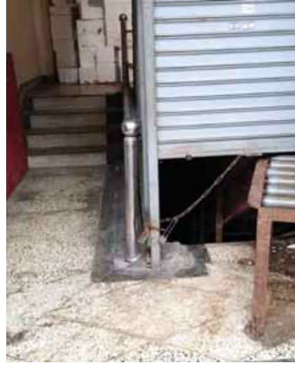
비상계단 막은 상자더미와 컨베이어벨트.
