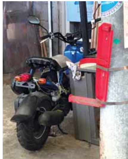
텅 빈 소화기 설치 공간.
