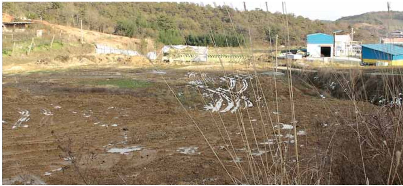
공사가 중단된 나주시 왕곡면 신포리 현장. 뒷편으로 현재 가동중인 A사의 축산폐수처리장이 보인다.
