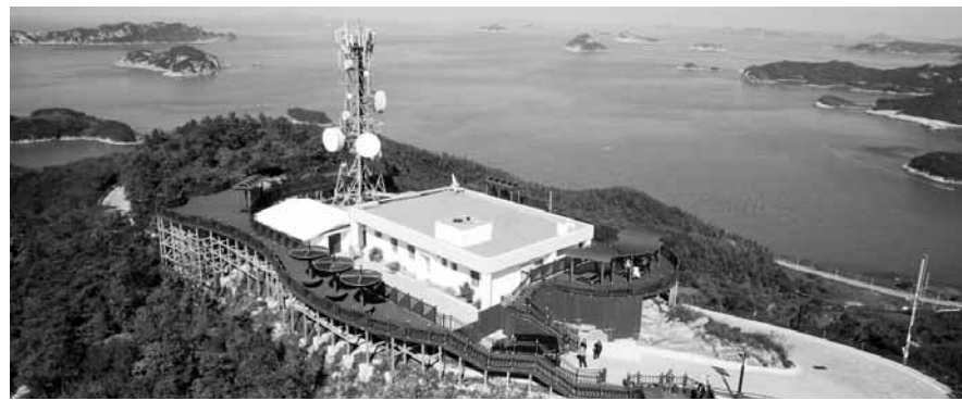
최근 완공된 진도군 조도면 도리산전망대 전경.
