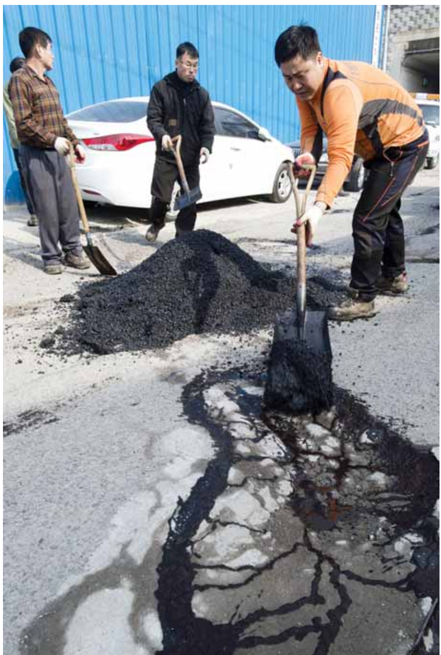
도로 포트홀 메우기
