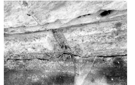
금이 간 옹벽 바닥면
