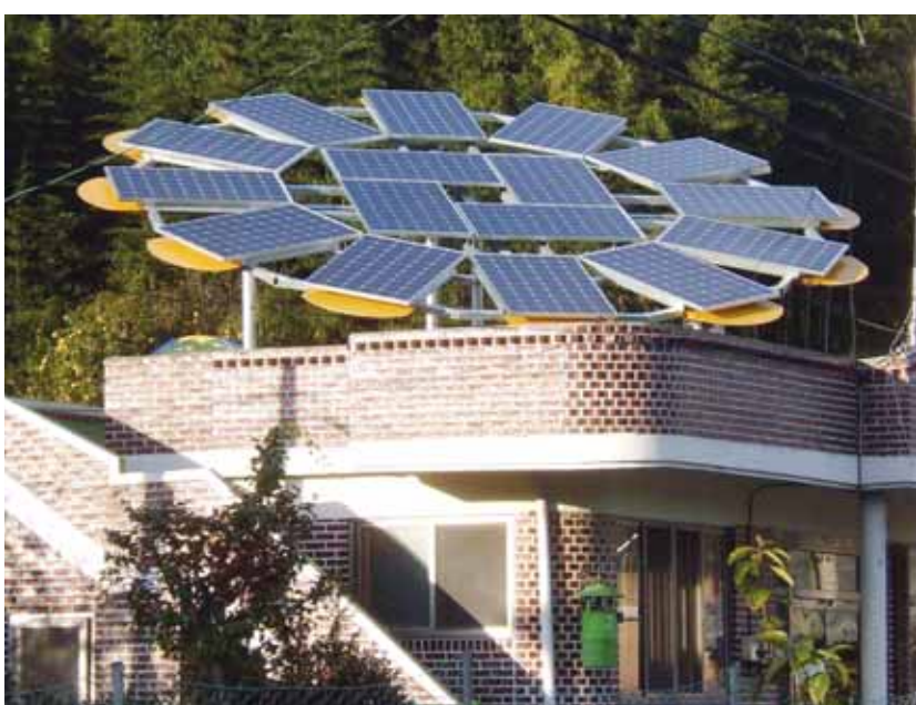
‘에너지 자립마을’인 순천시 아룡마을 주택 옥상에 설치된 태양광 발전시설.
