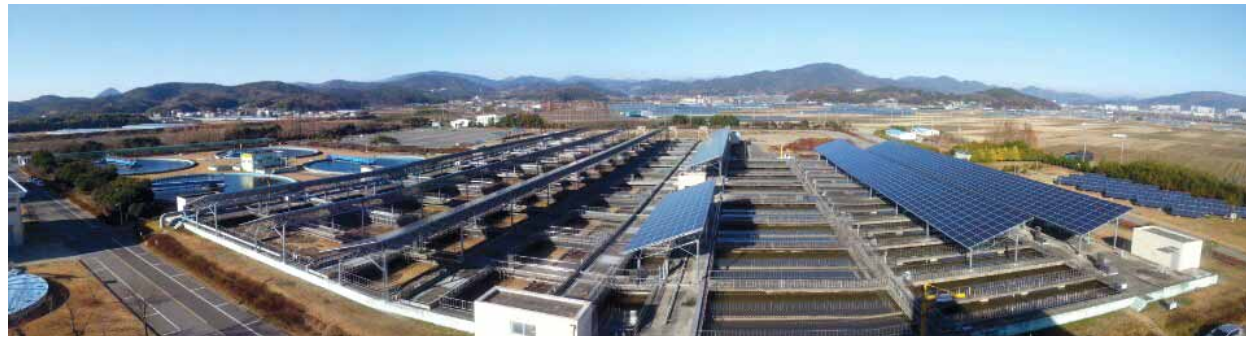
지난해 12월 시범가동에 들어간 순천시 공공 하수처리장내 태양광 발전소(총 996kW 규모).
