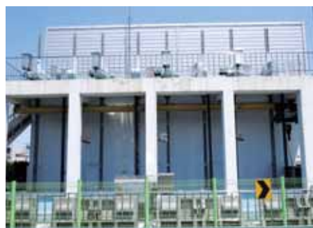
만호동 침수 부른 내항배수펌프장 단전
