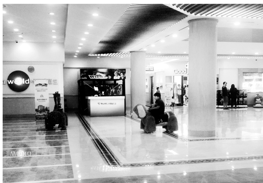
대명리조트 변산 측이 지하 1층 피난통로에 불법으로 5개 영업장을 설치, 운영하고 있다. 피난통로에 설치된 어린이 놀이기구와 자판기 모습.
