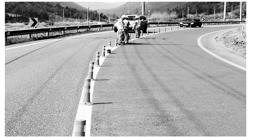
굵은 도로에 중앙분리봉(시선유도봉)을 설치하고 있는 모습.
