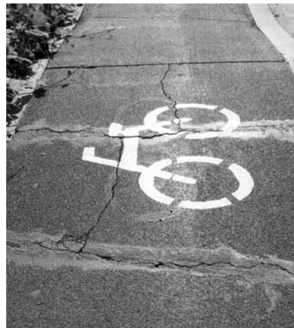
균열을 보수하지 않고 페인트 칠을 한 변산반도 자전거도로.
