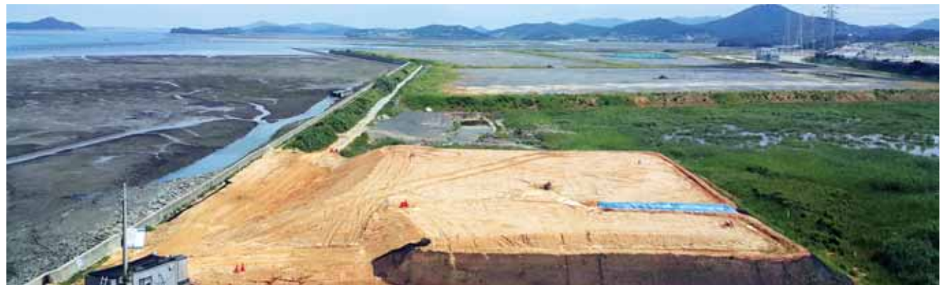
목포시 대양동에 조성중인 대양 일반산업단지 조성 현장.
