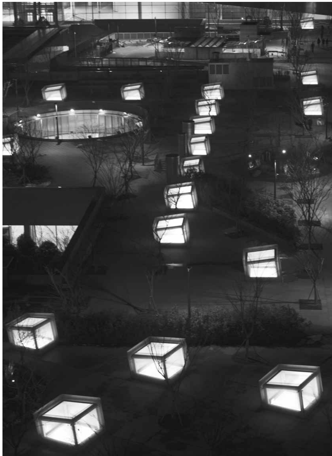
문화창조원과 정보원 옥상에 조성된 공원에는 시각형 유리시설물인 천창(天窓) 56개가 설치돼 있다. 천창은 주간엔 태양광을 지하 4층까지 끌어들이고, 밤에는 불을 밝히는 두 가지 역할을 한다.
