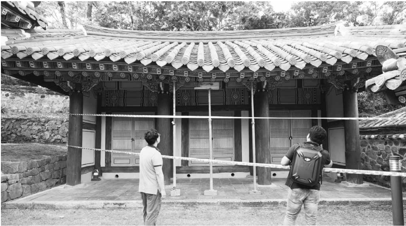
완도 고금도 총무사내 동무의 서까래가 무너질 위기에 놓이자 완도군이 붕괴 위험이 있는 곳을 철재빔으로 받쳐 놓았다.
