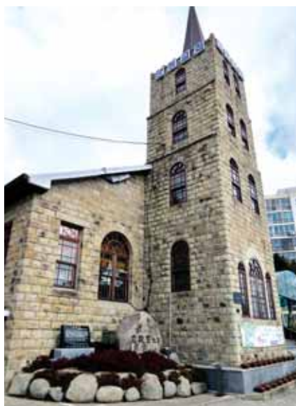
사업비 1억 5000만원을 들여 지붕 보수 공사중인 양동교회 전경.
