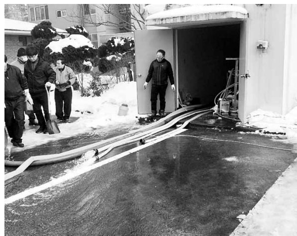
지하철 펌핑 작업
