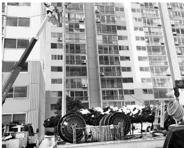
한전 비상전기 설치 작업
