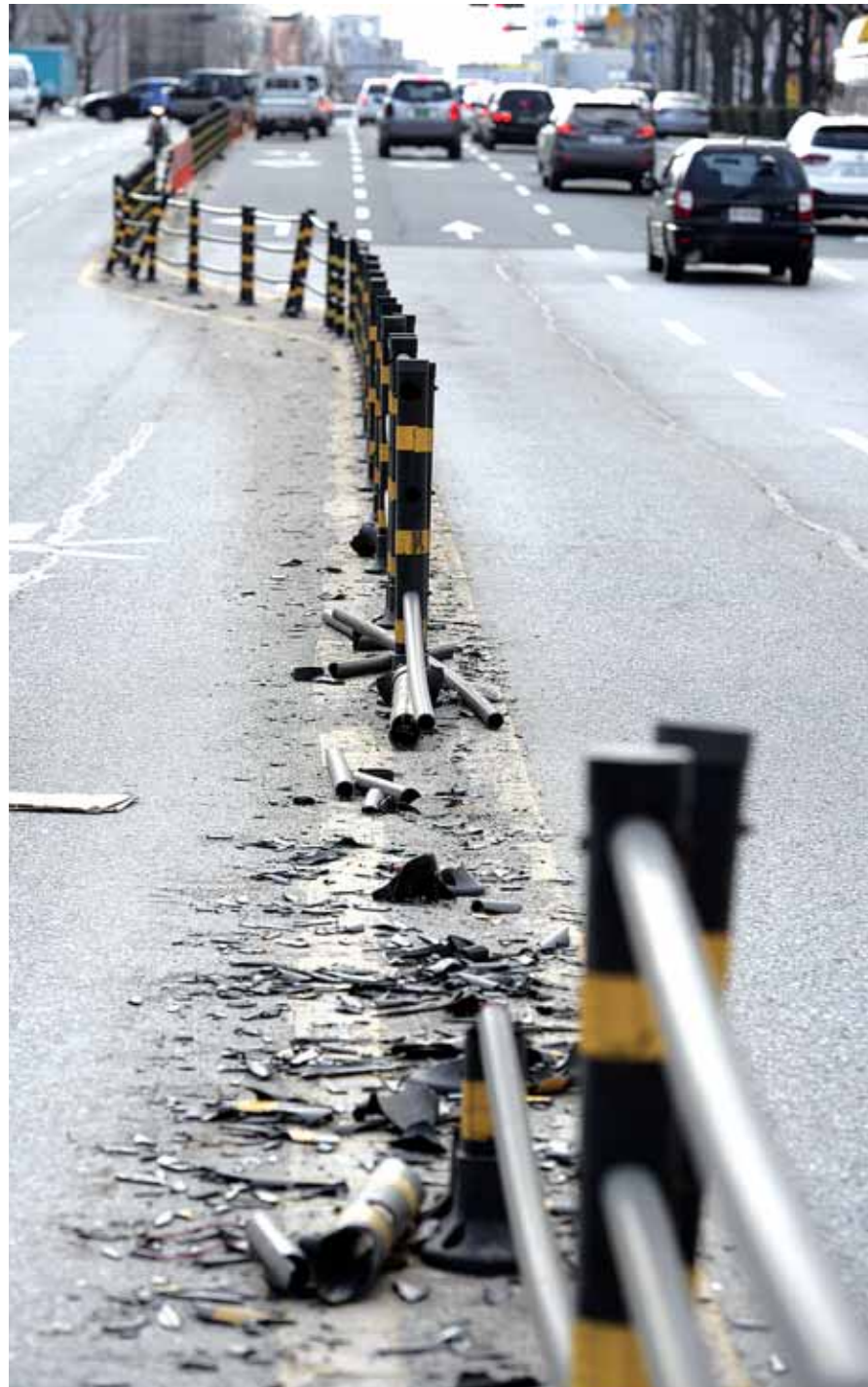
산수동 필문대로 중앙분리대 파손 방지
